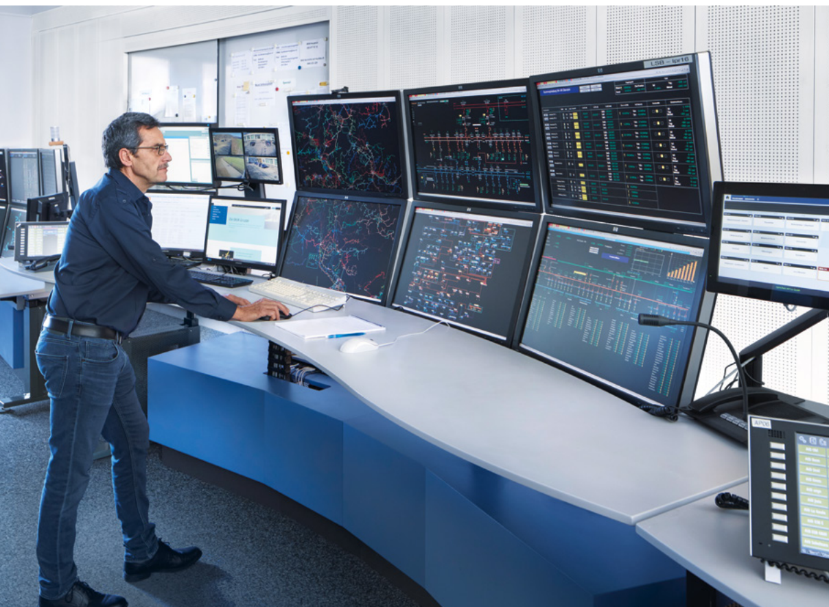
Surveillance du réseau de distribution de BKW depuis le centre d'exploitation de Mühleberg.
