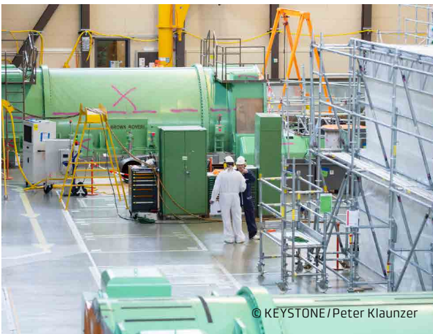
In den ersten Monaten nach der Abschaltung wurden im Maschinenhaus Turbinen, Generatoren und grössere Einzelkomponenten ausser Betrieb genommen und demontiert.
