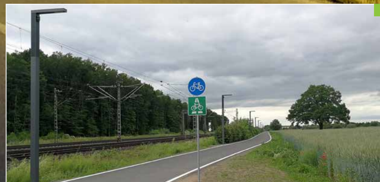
RADSCHNELLWEG FRANKFURT AM MAIN // DEUTSCHLAND / GERMANY
