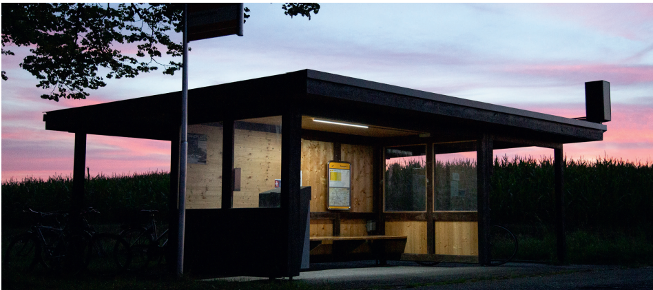
Solarleuchte «mara» (festinstalliert). Siehe auch «Referenz Oberdettigen» unter www.bkw.ch/solarleuchten .
