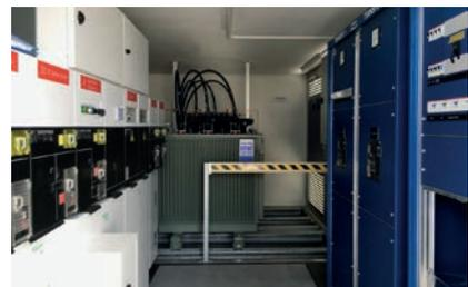
Blick in eine der drei Trafostationen, die zwischen zwei und vier Transformatoren enthalten.
