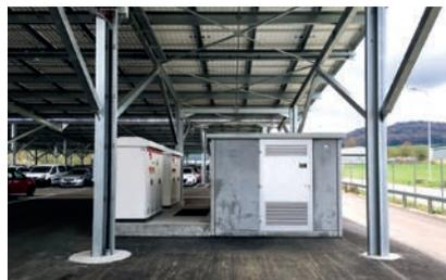
Blick in den Carport mit Trafostation und Wechselrichter.
