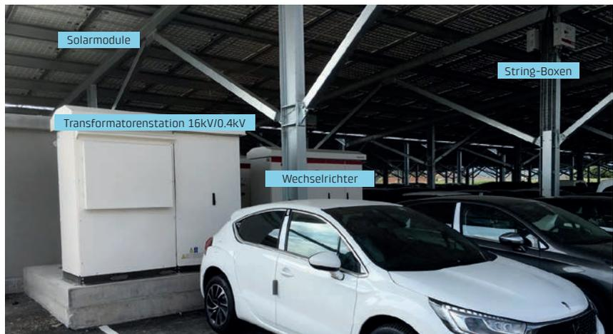
Solardach von unten, String-Box, Wechselrichter und Trafostation im Hintergrund.
