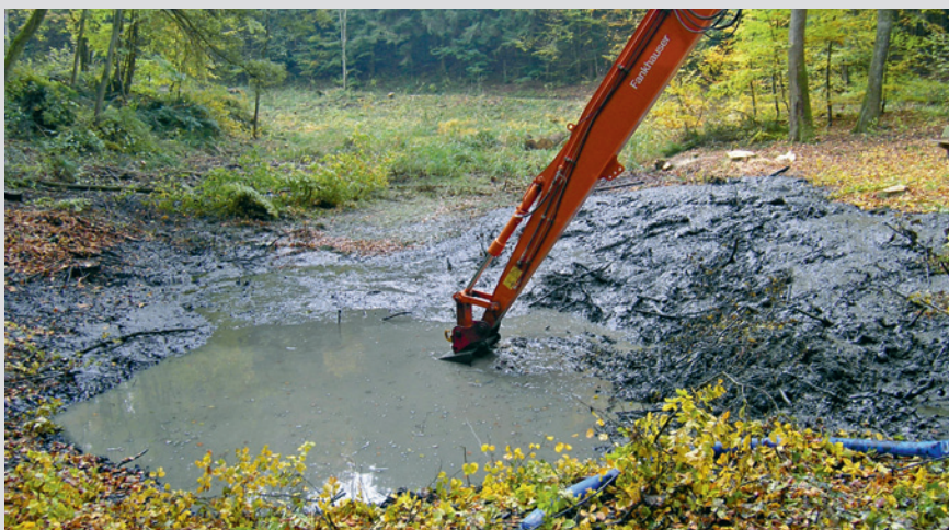
Das Gummenseeli wird revitalisiert.
