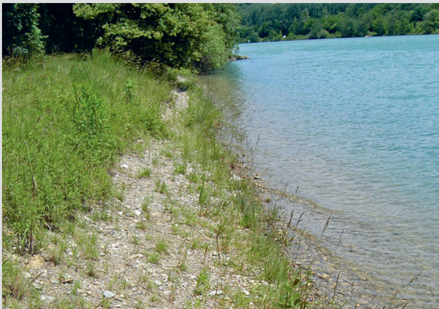
Stau Aarberg: Aufwertung der Ufer mit Kiesvorschüttung.
