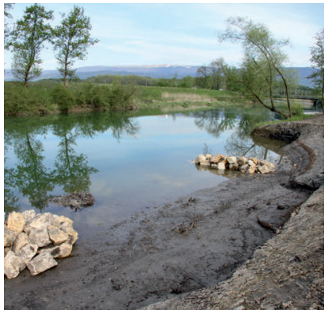
Der Kallnachkanal wird in ein naturnahes Gewässer umgestaltet.
