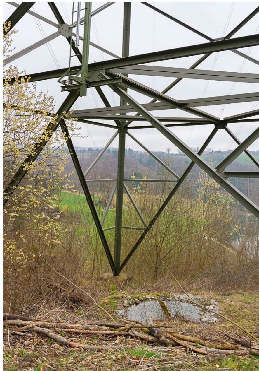
Un lieu idéal pour la reproduction: les mares sous les pylônes électriques
