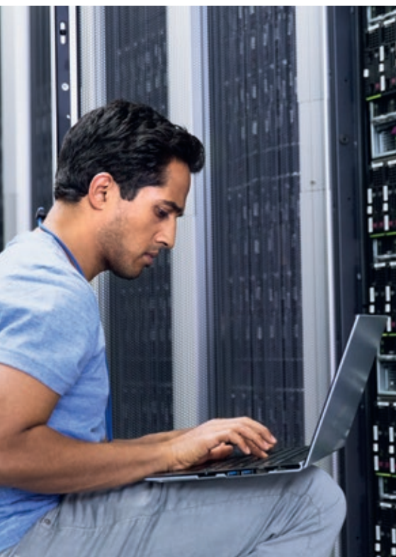
Konzentriertes Arbeiten in einem Serverraum.
