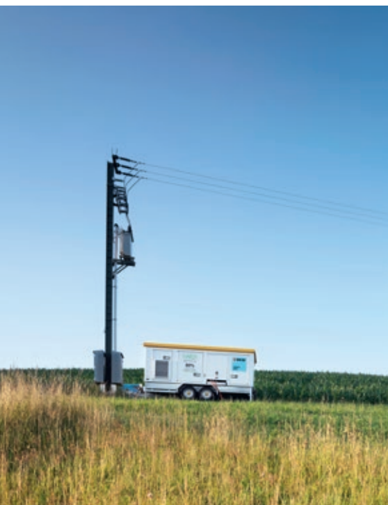
Mit ihrer hybriden Netzersatzanlage hält die BKW die Stromversorgung während Wartungsarbeiten umwelt- und ressourcenschonend aufrecht.
