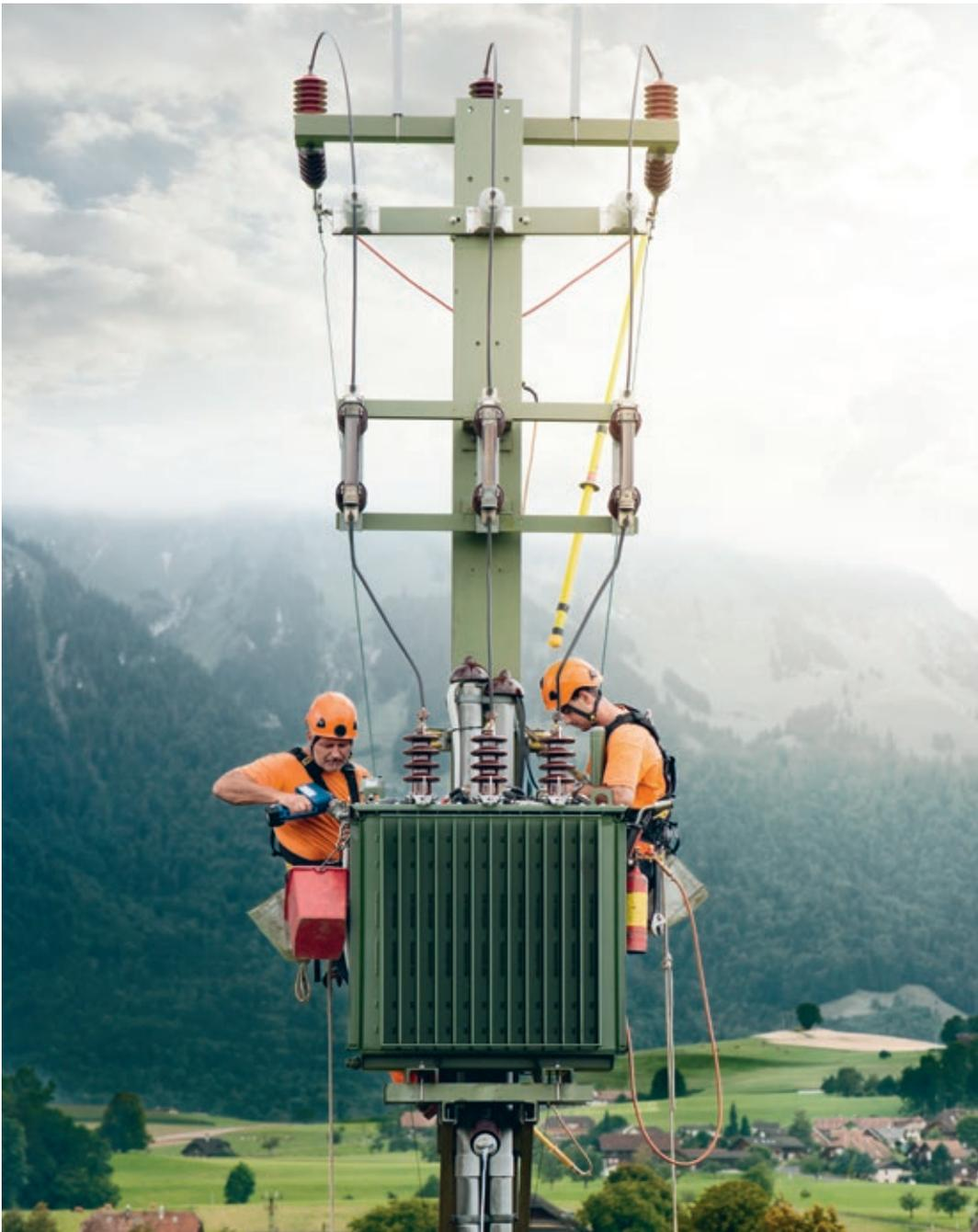
Dank intelligenter Technologie können die herkömmlichen Ortsnetztransformatoren wie im Bild zu sehen heikle Spannungsdifferenzen direkt im Netz regeln.
