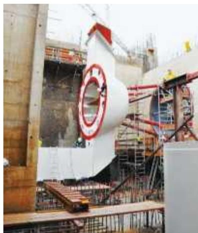
Wasserkraftwerk Hagneck: Versetzung eines Turbinengehäuses im Dezember 2013
